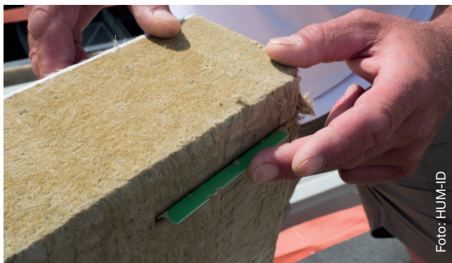
Die HUM-ID-Sensoren lassen sich einfach mit verbauen und auch nachrüsten.
